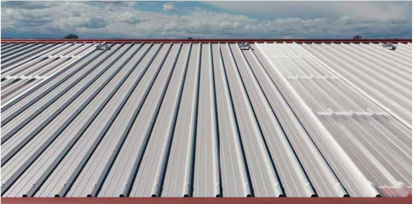
Pannello sandwich a doppio rivestimento metallico, per coperture con pendenza non inferiore a 7%, coibentato in poliuretano, con lamiera esterna profilata a 5 greche per aumentare la resistenza ai carichi statici e dinamici. Il fissaggio è a vista, con appositi cappellotti metallici e guarnizione. Trova impiego anche nel rivestimento di pareti.
